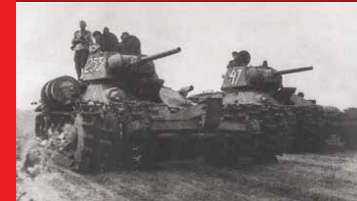
Советские танки Т-34 с противоминными трапами. Воронежский фронт, Харьковское направление, август 1943 г.
